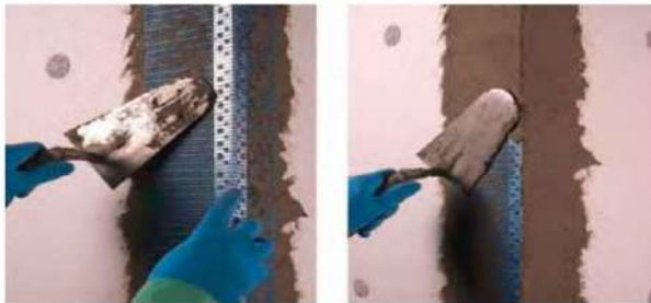
1. Colocación de toda la perfilería Danotherm asentada con Argotec Fixtherm.
