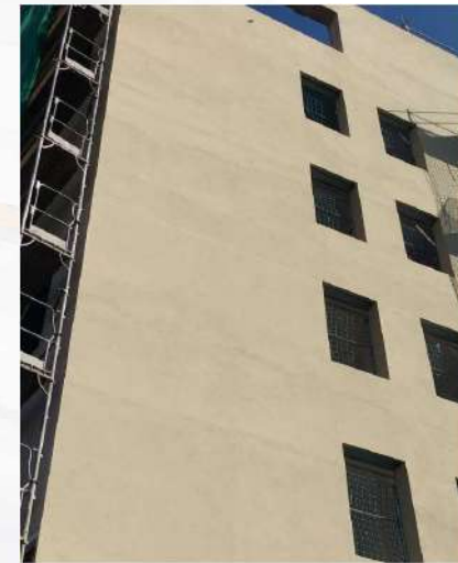
“Falta de planeidad fratasado irregular y junta de trabajo”
